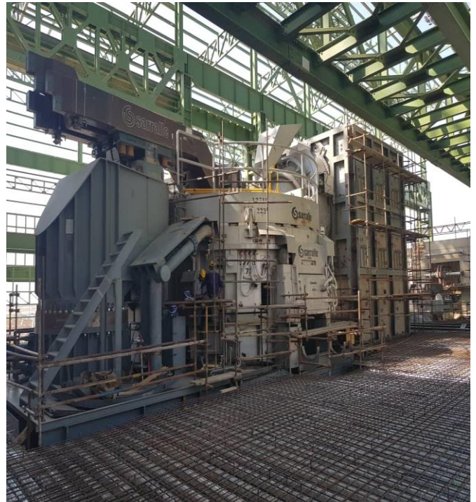
نصب کوره قوس الکتریکی
