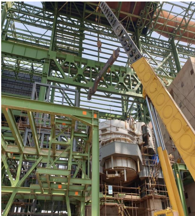
نصب کوره قوس الکتریکی
